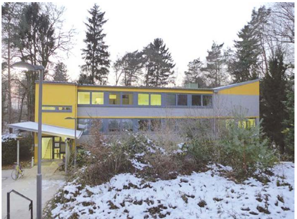
Seminargebäude auf dem Universitätsgelände in Saarbrücken.
